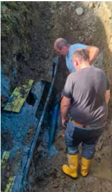
Behebung der Rohrbrüche
