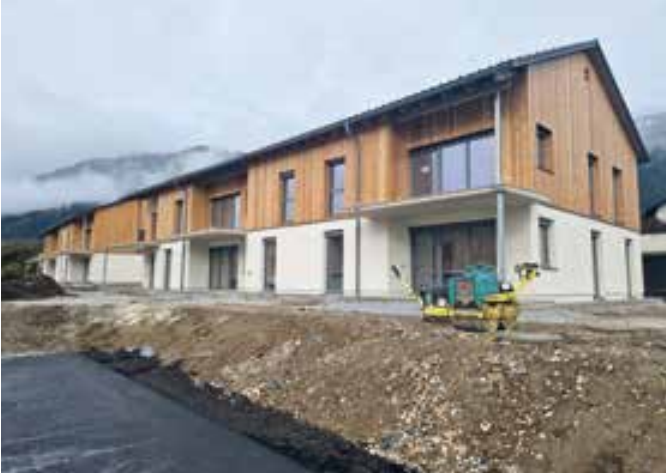
Hier entstehen 20 Wohneinheiten in bester Lage Übergabe erfolgt im Frühjahr 2024.
