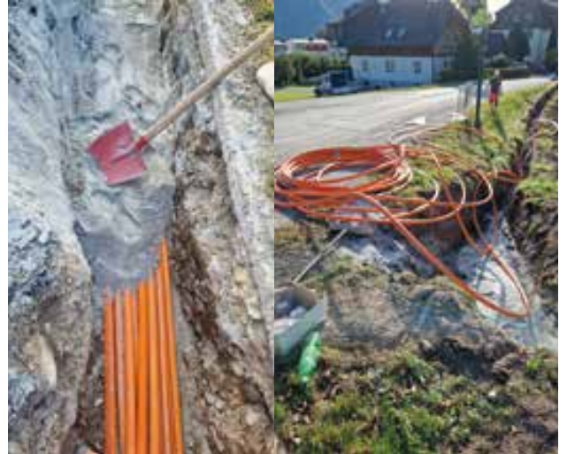
Verlegung der Haupttrasse nach Frauenberg
